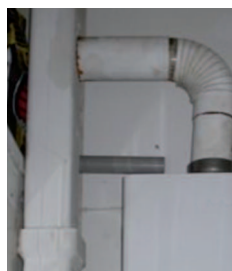
Débouché dans un conduit de ventilation
