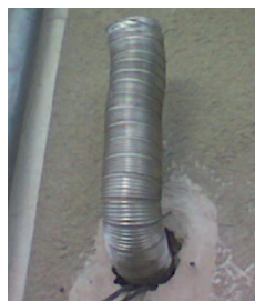
Débouché direct au travers d'un mur
