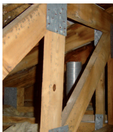
Débouché dans les combles
